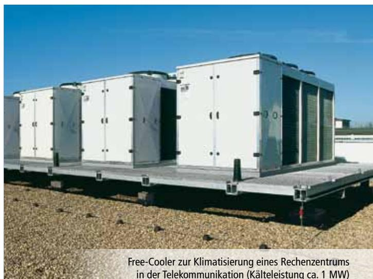
Free-Cooler zur Klimatisierung eines Rechenzentrums in der Telekommunikation (Kälteleistung ca. 1 MW)
