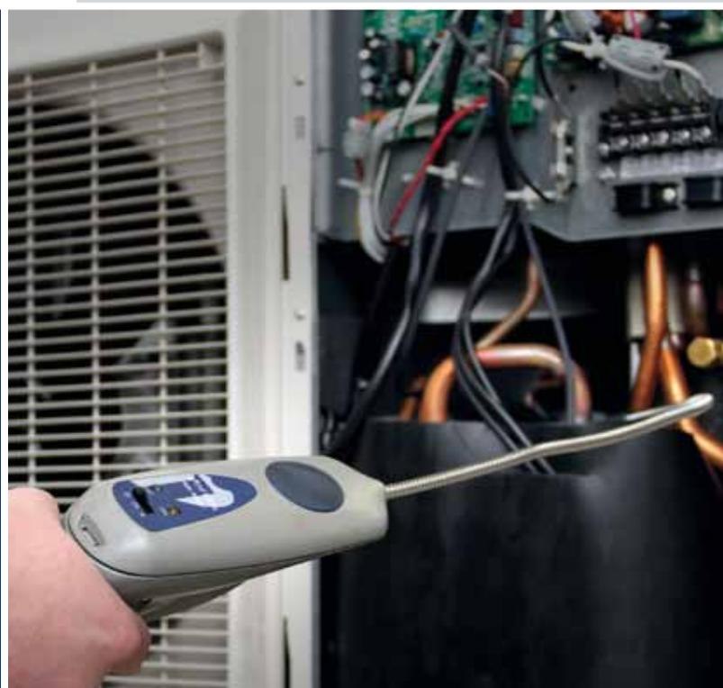
Gesetzlich vorgeschriebene Dichtheitsprüfung mit hochwertigem Lecksuchgerät.
